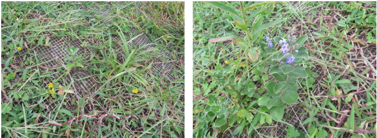
写真4 緑化状況近景 平成29年8月末（施工8ヶ月後）
