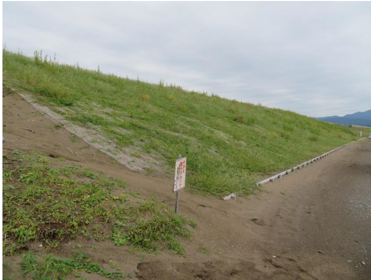
写真3 緑化状況 平成29年8月末（施工8ヶ月後）
