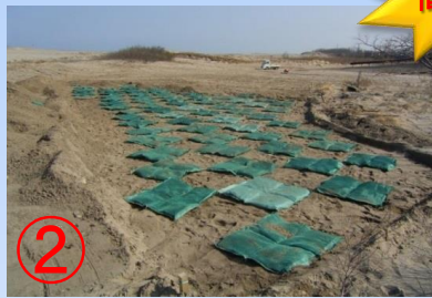
② はまみどりマット設置完了
